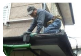
トイレ修理作業
