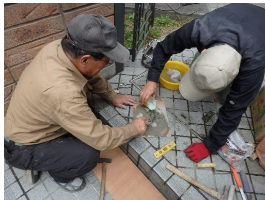
タイルの補修
