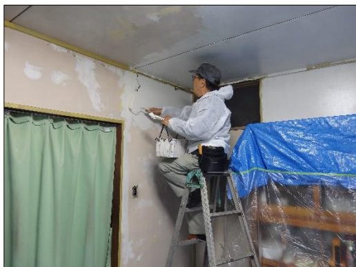
めじろ台 Y 邸の内装作業
