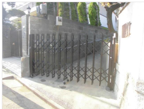
取り壊してフェンスに交換
