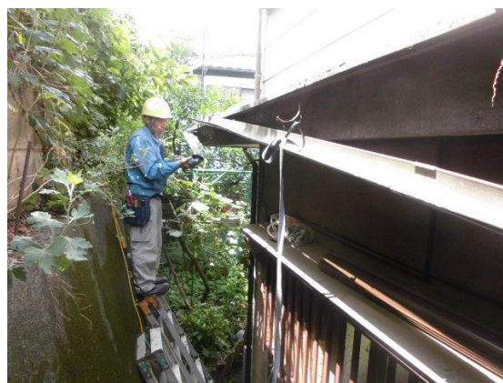
w 邸雨どい交換作業
