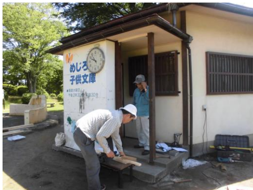
万葉公園子供文庫入り口に扉設置
