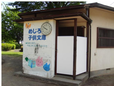
子供文庫入り口扉完成
