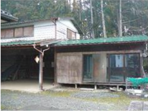
山田町内田邸納屋の資機材置き場
