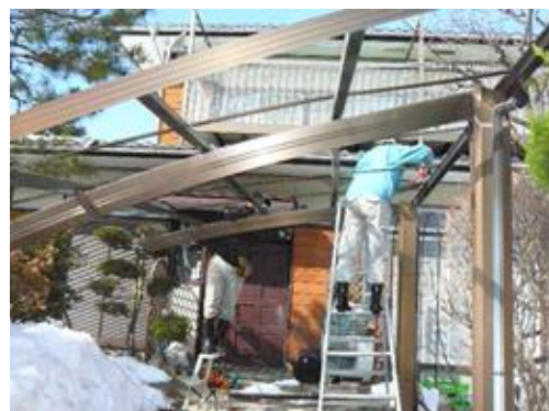
カーポートの撤去
