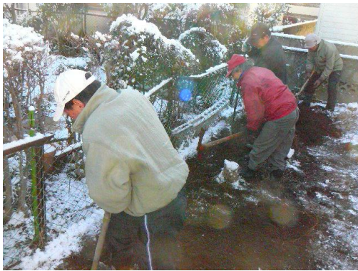
隣家境界に溝を掘り、 鉄板を入れて根の進入を防ぎます
