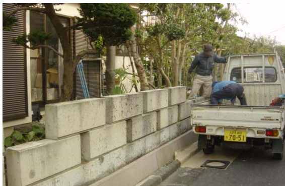
M 邸大谷石塀の補強作業
