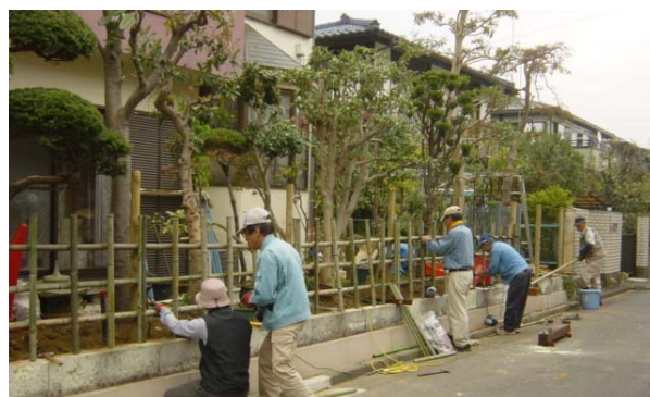
K 邸大谷石塀から生け垣設置作業（以下3枚）
