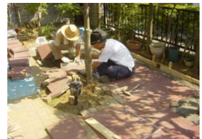
平板ブロック敷設
