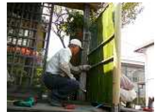
生活支援 竹垣設置
