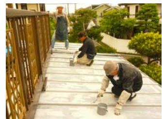
屋根のペンキ塗り
