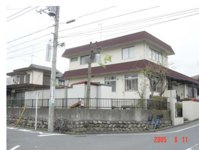
作業完了後のめじろ台第1会館
